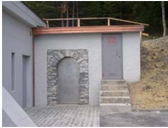
Nouvelle sortie du tunnel aux Mayens-de-la-Zour (2004)
