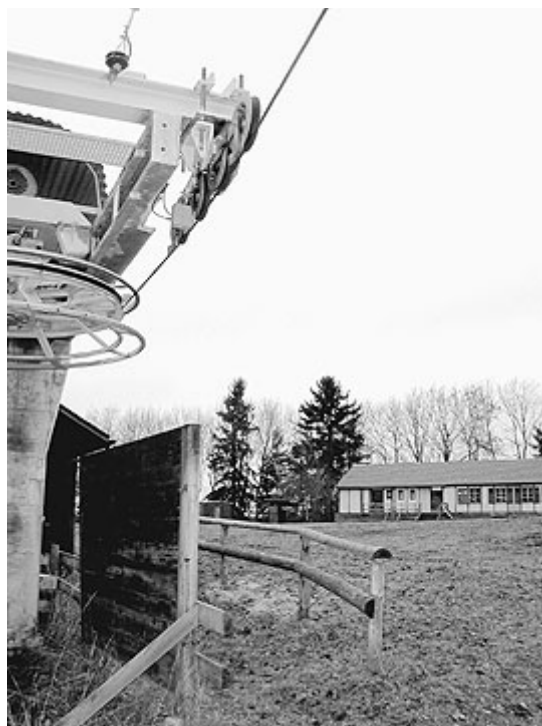
Les installations ne sont plus exploitées depuis 2001 et la buvette, vétuste, n'est louée que sur décharge préalable
