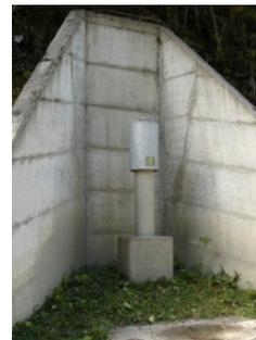
*Certaines chambres d'aération, servant à faciliter l'écoulement libre des eaux dans la conduite, ont dû être protégées des chutes de pierres par un ouvrage en béton.*
